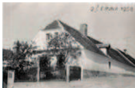
čp. 34 - před rekonstrukcí, rok 1958
