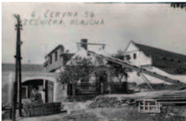
Rekonstrukce domu čp. 34 (u Šounů)
