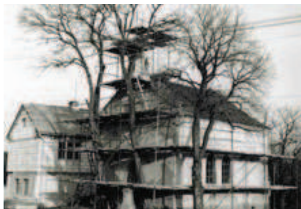
Kaplička při opravě v roce 1983
