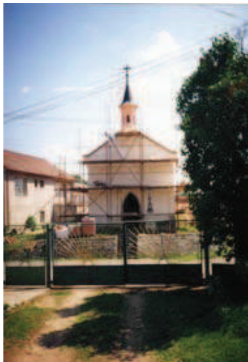
Oprava kapličky v roce 1997
