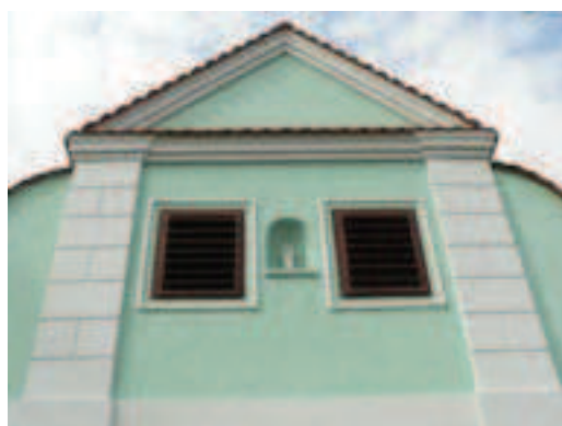
Hospodářská část objektu čp. 4
