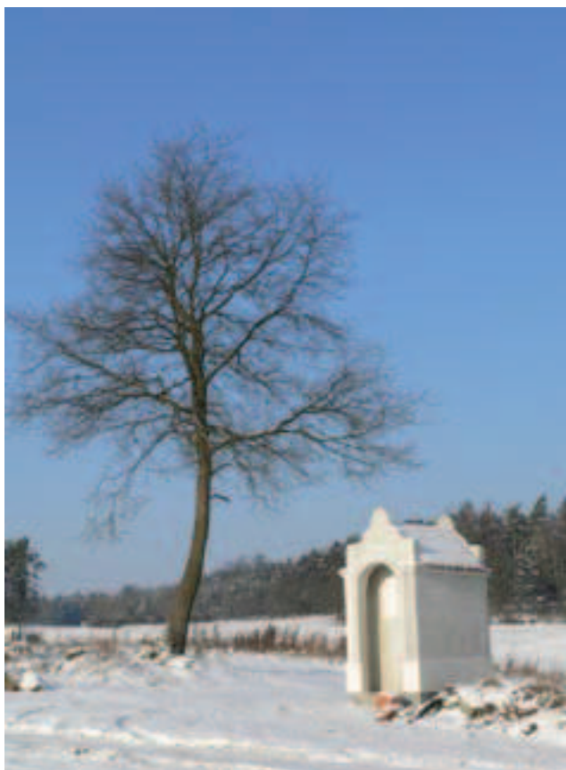
Novodobá kaplička ukrývající elektroměrný pilíř
