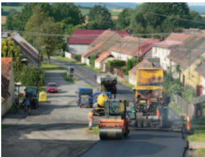
Oprava silnice v roce 2010
