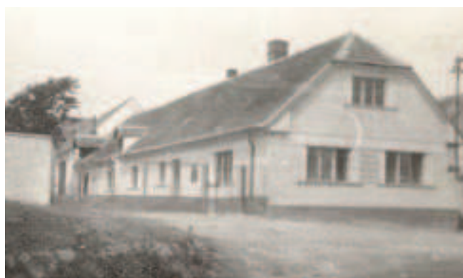
Objekt čp. 3 před rekonstrukcí
