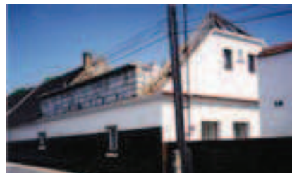
čp. 14 při rekonstrukci, 1997
