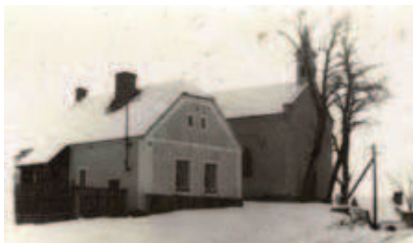
Domek čp. 23 před rekonstrukcí
